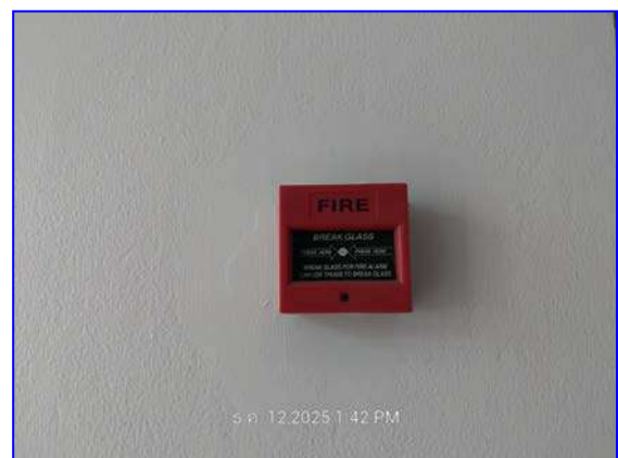
รูปที่ 2.11 อุปกรณ์แจ้งเตือนเหตุเพลิงไหม้
