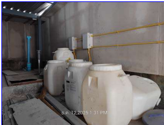
รูปที่ 2.24 ระบบบำบัดน้ำเสีย
