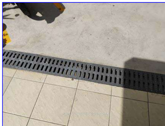
รูปที่ 2.31 ตะแกรงดักขยะและรางระบายน้ำ
