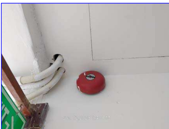
รูปที่ 2.11 อุปกรณ์แจ้งเตือนเหตุเพลิงไหม้
